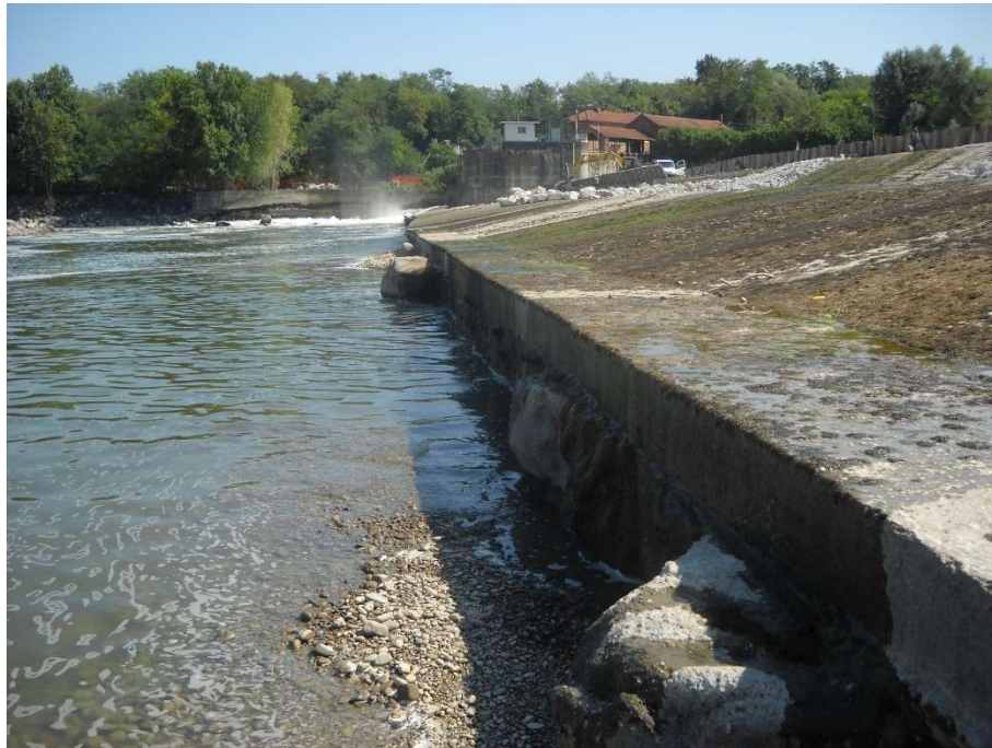
Figura 2: Vista ringrosso di valle e rivestimento in cls (foto 2014)
