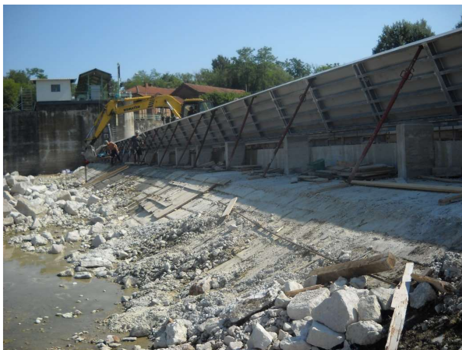
Figura 6: Particolare lavori di realizzazione sovrizzo mobile (2013)
