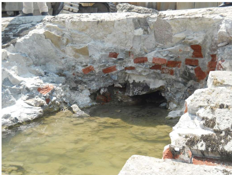
Figura 5: Dissesto del corpo originario della traversa
