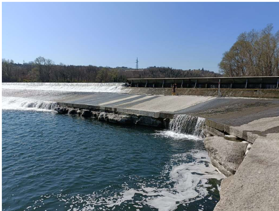
Figura 3: Vista ringrosso di valle e rivestimento in cls (foto 2022)
